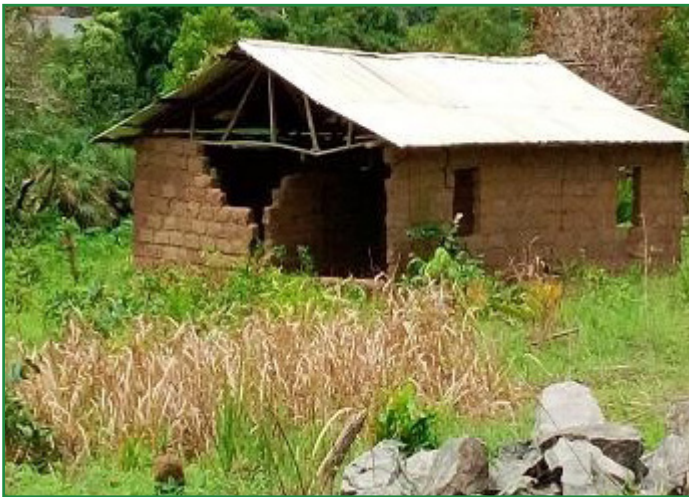
Maisons détruites à cause des vibrations issues des tirs des explosifs de la carrière
