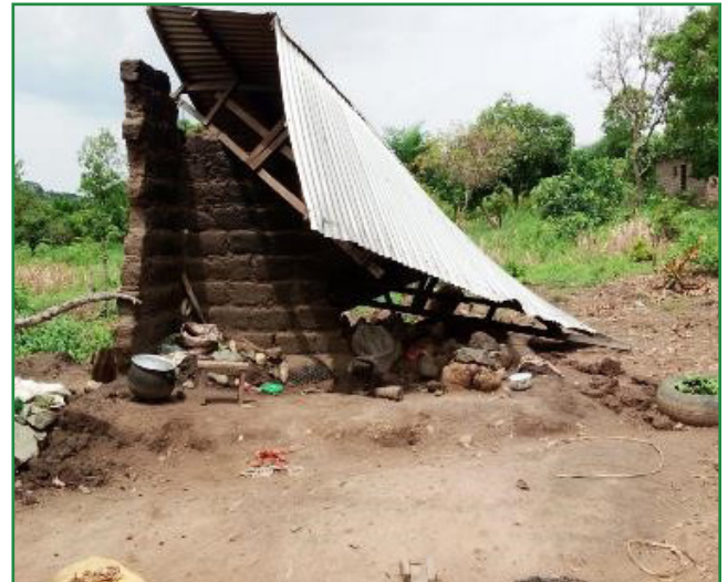
Maisons détruites à cause des vibrations issues des tirs des explosifs de la carrière
